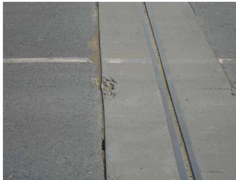
病害情况：伸缩缝边缘与原路面联接不紧密，长期车辆碾压形成坑槽；
