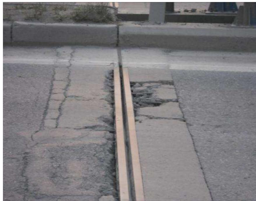
病害情况：固定伸缩缝的钢筋已经露出，对车辆行驶造成极大安全危害。
